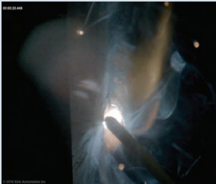
手工电弧焊接
