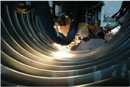
TIG内壁焊接
